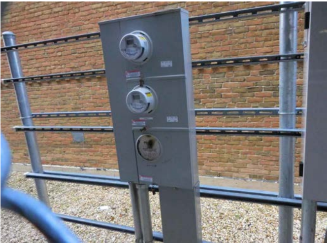
4 EXISTING METER CENTER/ FRAME SCALE: N.T.S.
