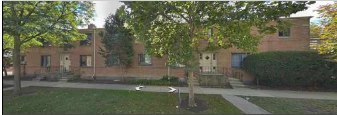
1 EXISTING PHOTO CS1.0 Scale: N.T.S.
